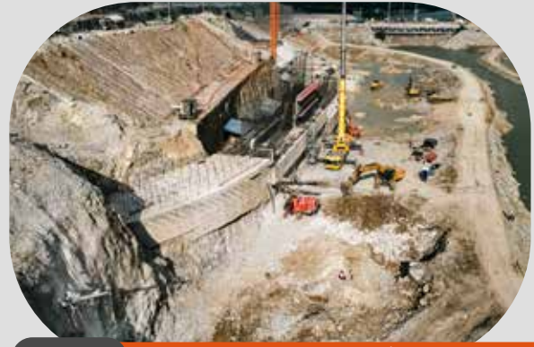
APYCSA PROYECTO: HIDROELÉCTRICO CH-II
