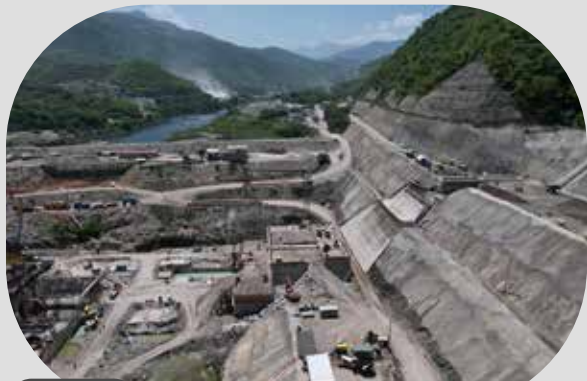
APYCSA PROYECTO: HIDROELÉCTRICO CH-II
