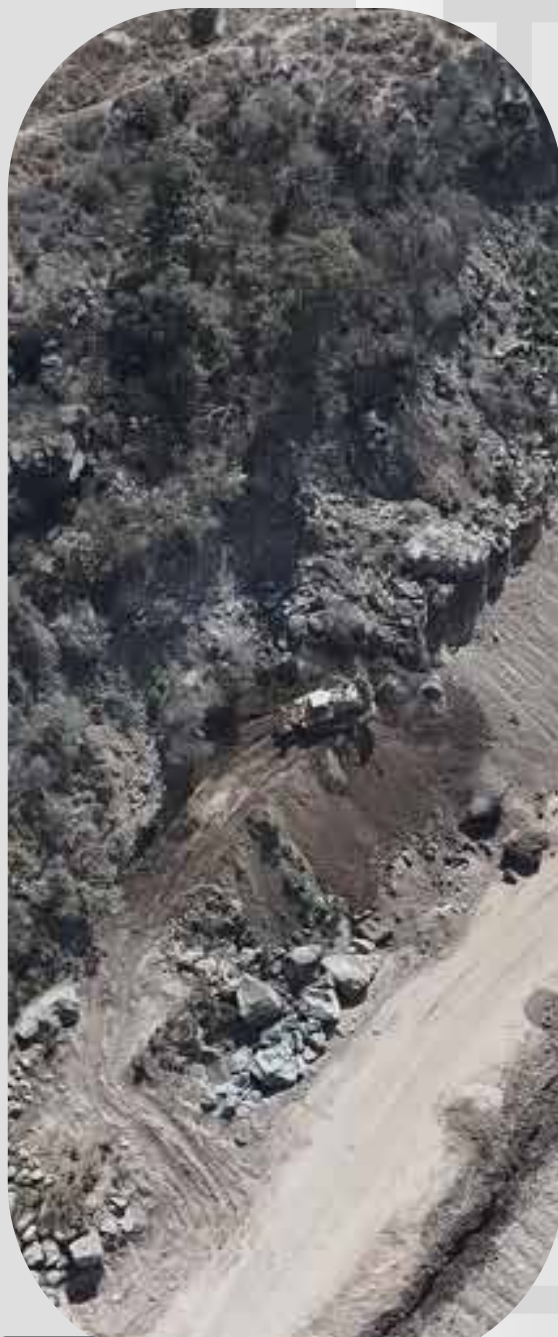
RESA CONSTRUCCIÓN DE CELDAS
