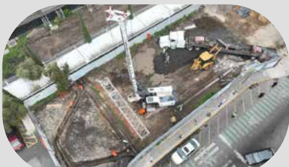
APYCSA PROYECTO: CABLEBÚS L6
