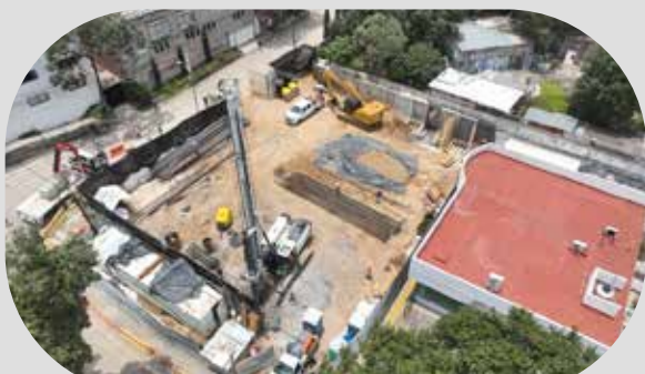
APYCSA PROYECTO: CABLEBÚS L4
