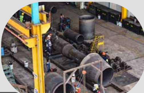
GEFSA PROYECTO: CABLEBÚS L6
