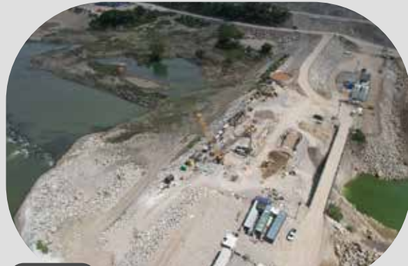
APYCSA PROYECTO: HIDROELÉCTRICO CH-II
