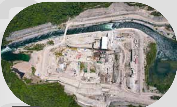
APYCSA PROYECTO: HIDROELÉCTRICO CH-II
