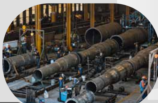
GEFSA PROYECTO: CABLEBÚS L4
